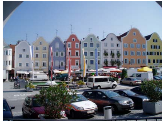
Firmensitz der Heliotec in Schärding (A) – Silberzeile bis Okt. 05
